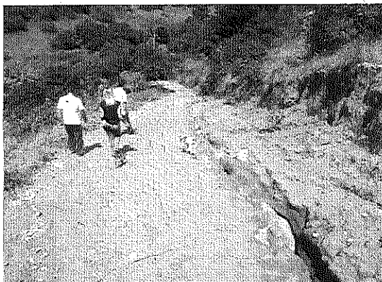
Foto 03: Estrada de acesso à área de lavra
