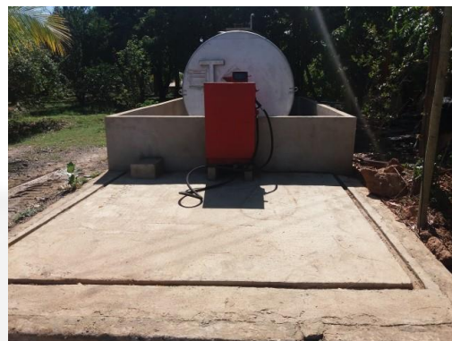
Foto 2: Tanque aéreo, com canaletas e sem cobertura.
