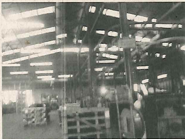
Foto 01. Galpão de produtos acabados
