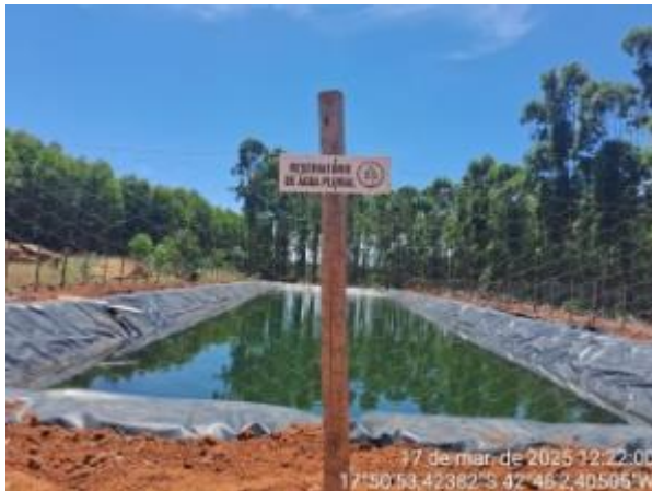
Foto 14. Tanque de armazenamento de água pluvial
