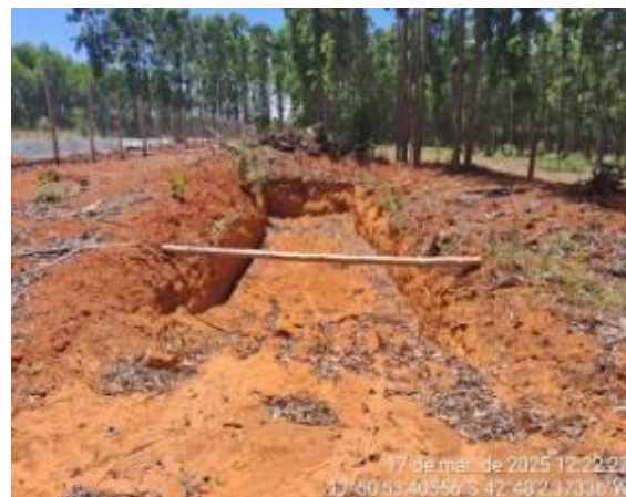
Foto 15. Bacia de contenção de sedimentos
