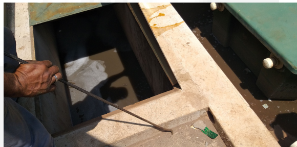
Caixa separadora de água e óleo
