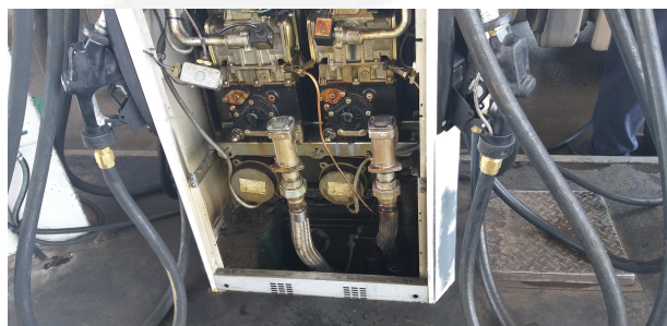
Bomba de combustível com sump e check valve
