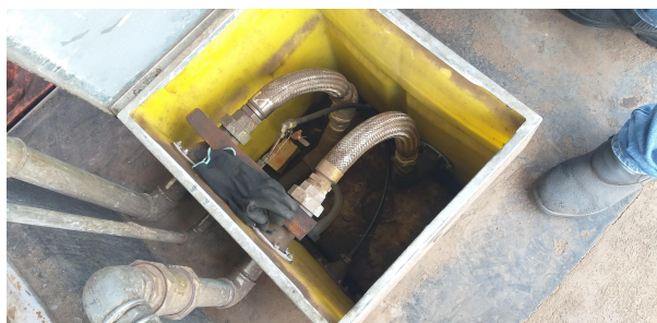
Sump do filtro de diesel
