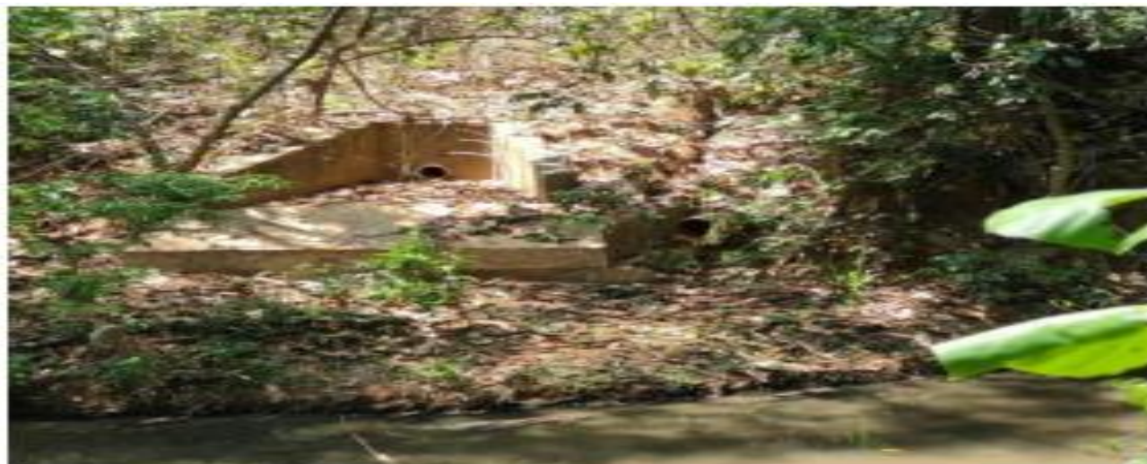
Figura III Lançamento de efluente tratado na APP Córrego Tropeiro – estrutura implantada:
