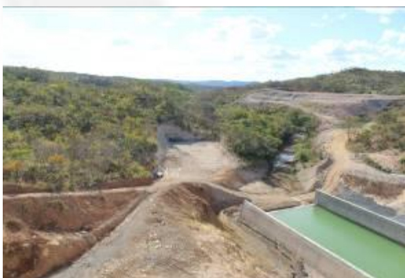
Foto 03. Visão a jusante do barramento: bacia de dissipação e área do canteiro de obras.
