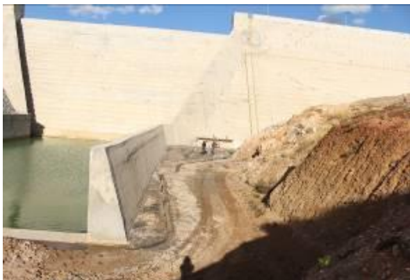
Foto 05. Vertedouro, bacia de dissipação e sistema de descarga de fundo.
