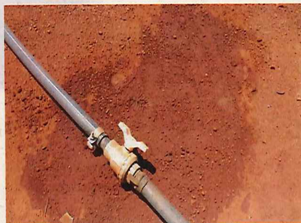
Foto 02. Vazamento identificado em uma das tubulações de ligação entre a lagoa e o reservatório de efluentes
