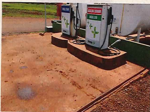
Foto 09. Área de abastecimento
