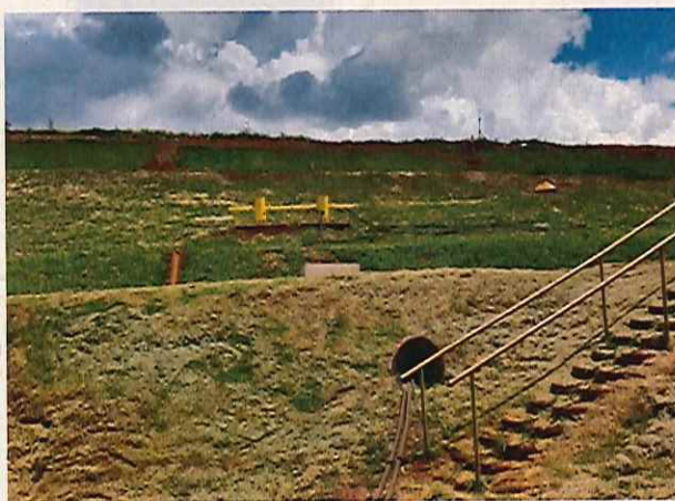
Foto 03. Taludes gramados do aterro classe II
