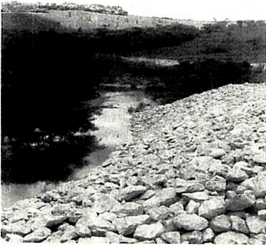
Foto 7- Leito do rio Macaúbas após o canal de fuga - Canal de restituição
