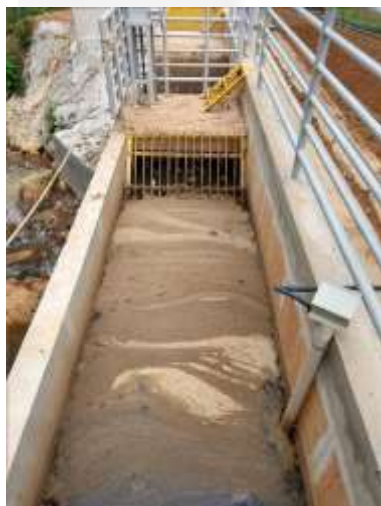
Foto 03. Medidor de vazão.
