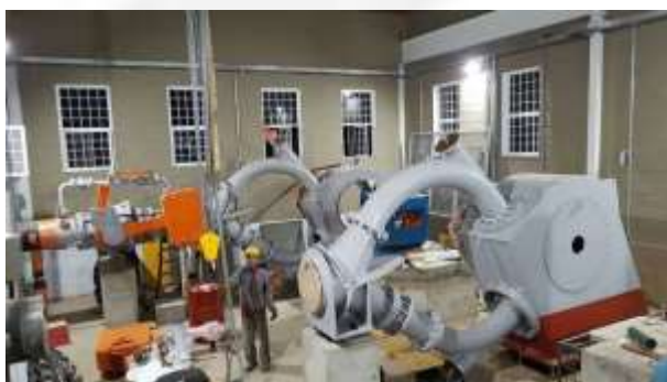
Foto 07. Turbinas e geradores (instalação).
