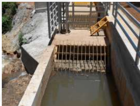
Foto 02. Gradeamento do canal adutor.
