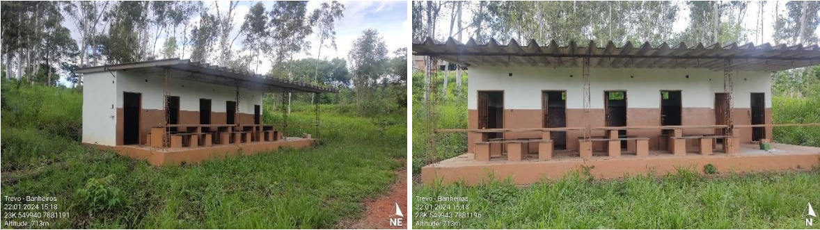
Banheiros, próximo a casa de bombas;
