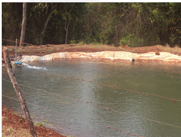
Foto 03. Captação superficial – tanque de acumulação de água
