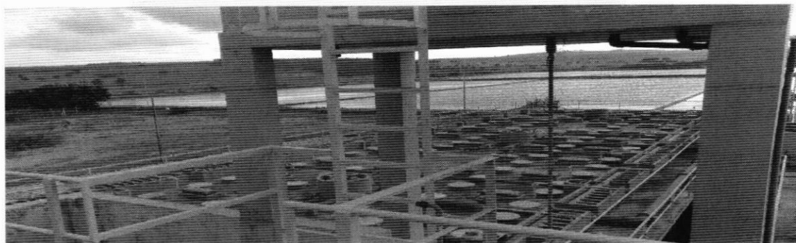
Foto 03: Reatores UASB
