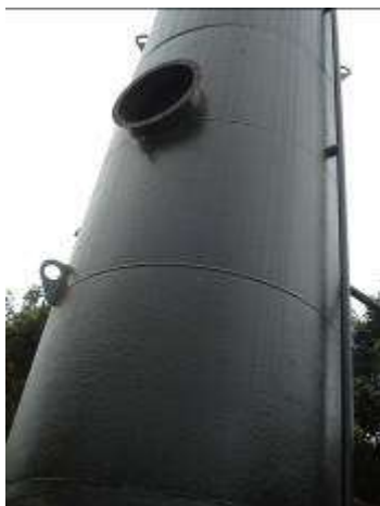
Foto 05. Separador de água e óleo.
