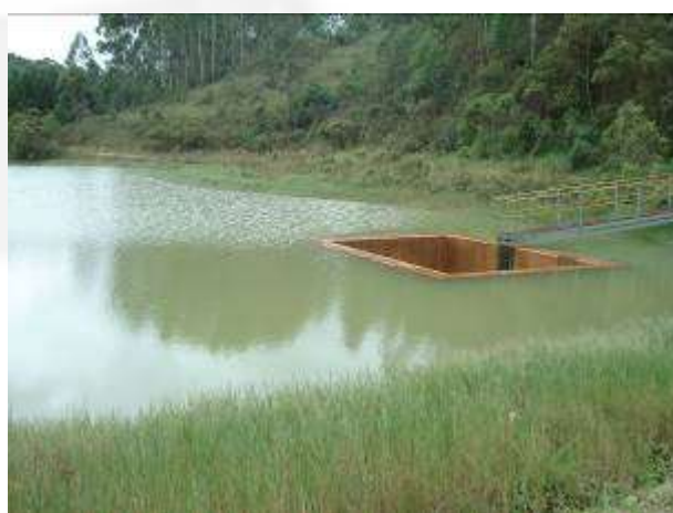
Foto 10. Vertedouro (tulipa retangular).
