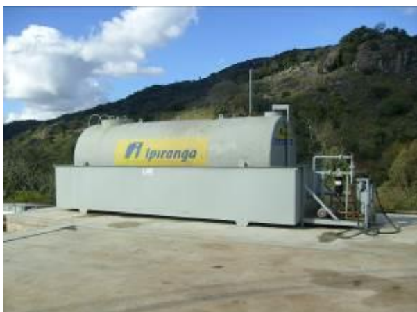
Foto 05. Ponto de abastecimento.
