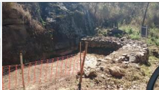
Foto 12. Bacia de contenção de finos.
