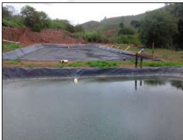
Lagoa Anaeróbia 1 ao fundo e lagoa secundária em primeiro plano.
