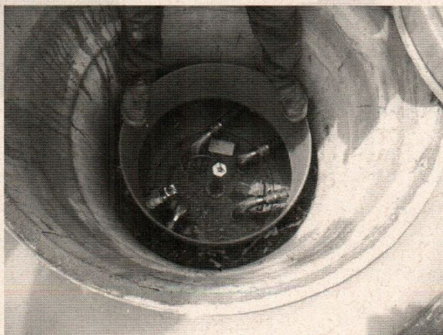
Boca de visita de tanque
