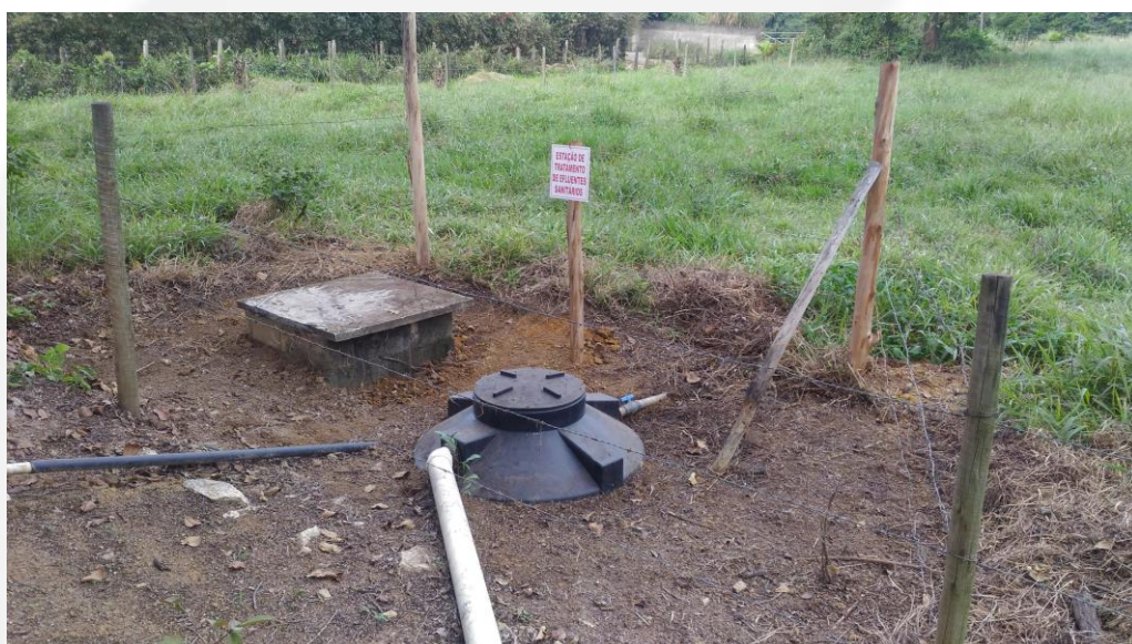
Figura 05: Sistema de tratamento de efluente sanitário.
