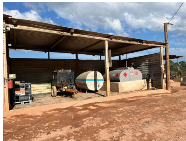
Foto 06. Ponto de Abastecimento impermeabilizado com contenção. Ao lado área de manutenção de equipamentos.
