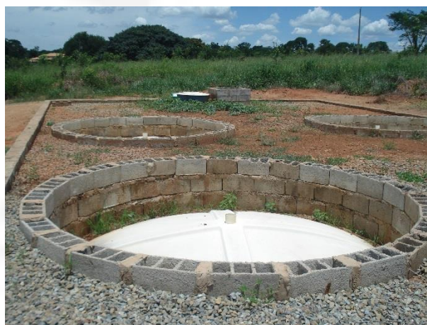
Foto 02. Sistema integrado de fossas sépticas
