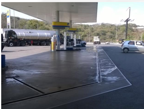
Foto 01. Área de abastecimento de veículos
