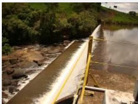
Foto 01. Vertedouro do barramento.
