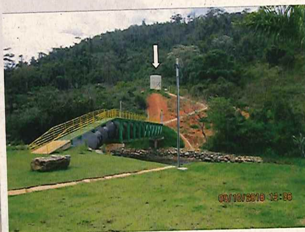
Figura 02: Chaminé de equilíbrio ao fundo e travessia do conduto
