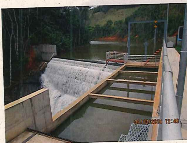
Figura 01: Barramento e tomada d'água
