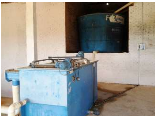
Foto 05. Vista do tanque de equalização de 10 m 3 (fundo da imagem). A tubulação que chega ao mesmo vem do tanque de recepção/desarenador (foto 4) e a que sai segue para o equipamento da frente – Flotador SCAF. A tubulação que sai do flotador segue para o leito de secagem – foto 6.
