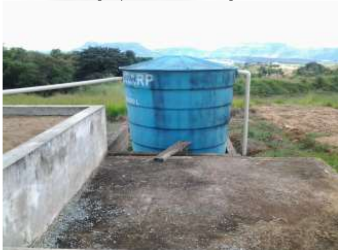
Foto 07. Vista do filtro biológico de 15m 3 com tubulação de entrada (flotador) e a de saída (filtro de areia).
