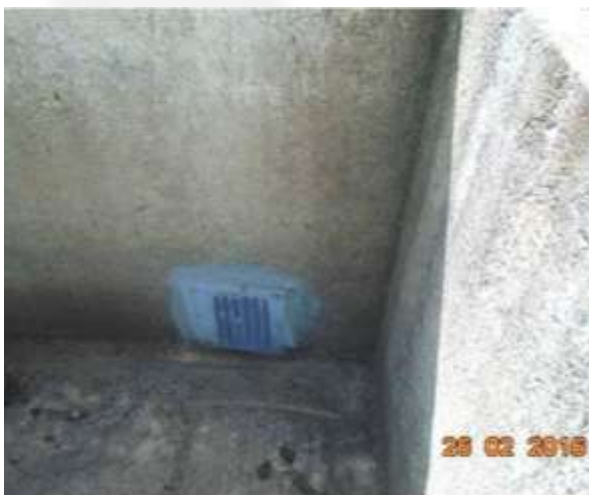
Foto 03. Vista de grade e peneira localizada dentro dos tanques de recepção, a peneira consiste em uma tela de malha fina sobre a grade. Obs.: foto enviada como IC.
