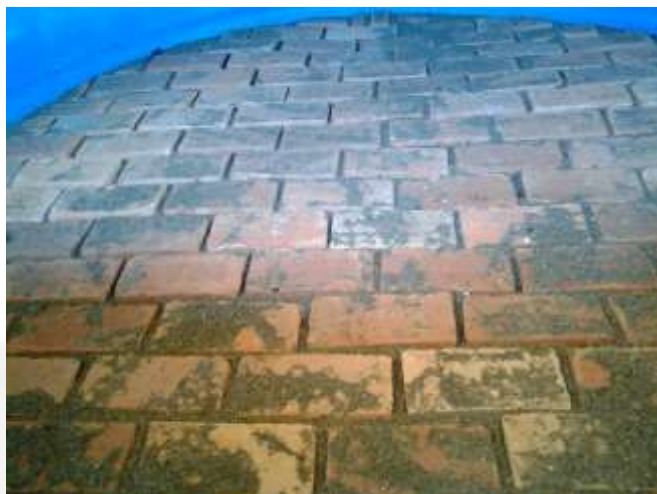
Foto 06. Vista parcial do leito de secagem. O sistema de tratamento conta com 02 leitos de secagem. A estrutura de ambos consiste em uma câmara montada em um tanque de fibra de vidro de 3 m 3 contendo camadas filtrantes formada por brita, areia e tijolo maciço.
