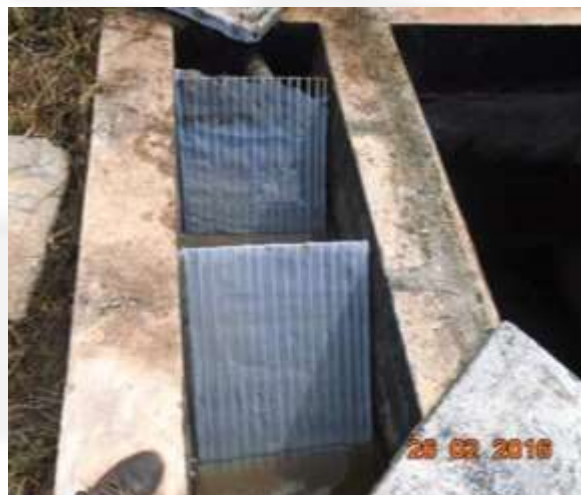
Foto 04. Vista de grade e peneira localizada dentro do desarenador, que é conectado a um tanque de recepção que desagua no tanque de equalização. Obs.: foto enviada como IC.
