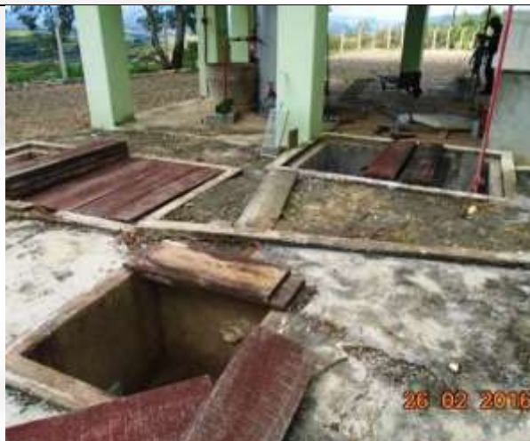
Foto 02. Vista dos 03 tanques de recepção, sendo 01 para recepção do sangue in natura; 01 para a linha vermelha e 01 para linha verde. Obs.: foto enviada como IC.
