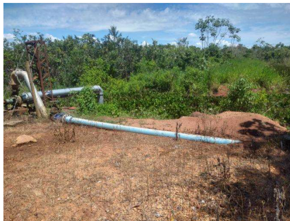
Foto 04. Tubulação e bomba para captação de água no Rio Paranaíba
