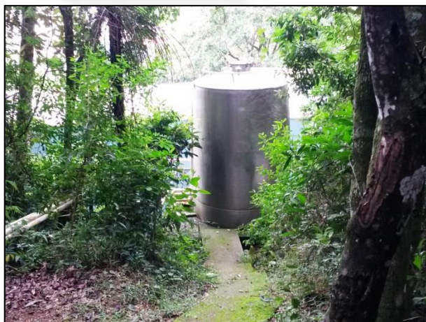
Foto 3 – Tanque inoxidável de armazenamento de água para envase.
