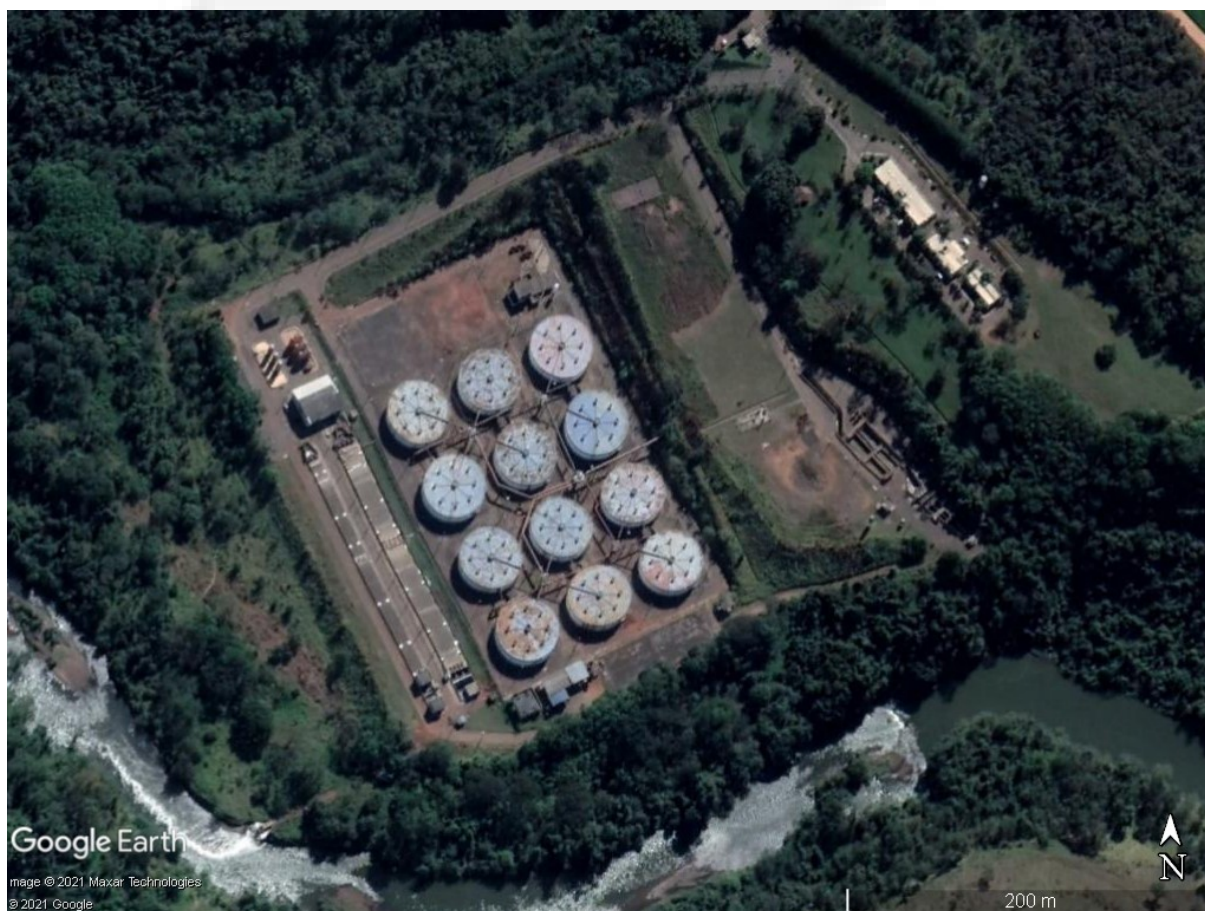
Figura 1: Localização e área do empreendimento (imagem – 26/06/2020).
