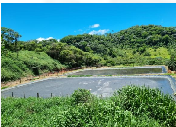
Imagem 03 e 04: caixa de contenção de sólidos e lagoas anaeróbias.
