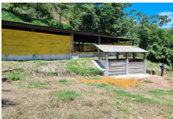
Imagem 05 e 06: composteira com canaleta para contenção de chorume.
