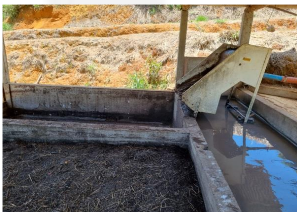
Imagem 03 e 04: caixa de contenção de sólidos e lagoas anaeróbias.
