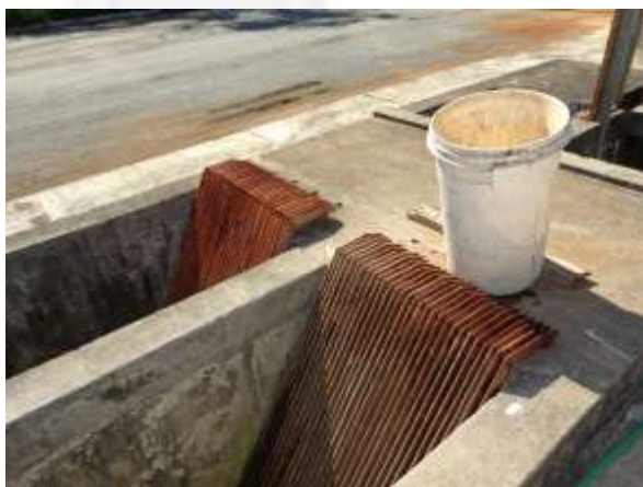
Tratamento preliminar - Gradeamento
