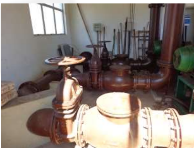
Conjunto Moto-Bomba – Elevatória de Esgoto
