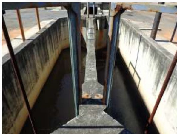
Tratamento preliminar - Desarenador
