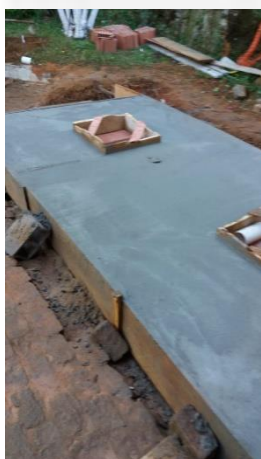
Tanque séptico
