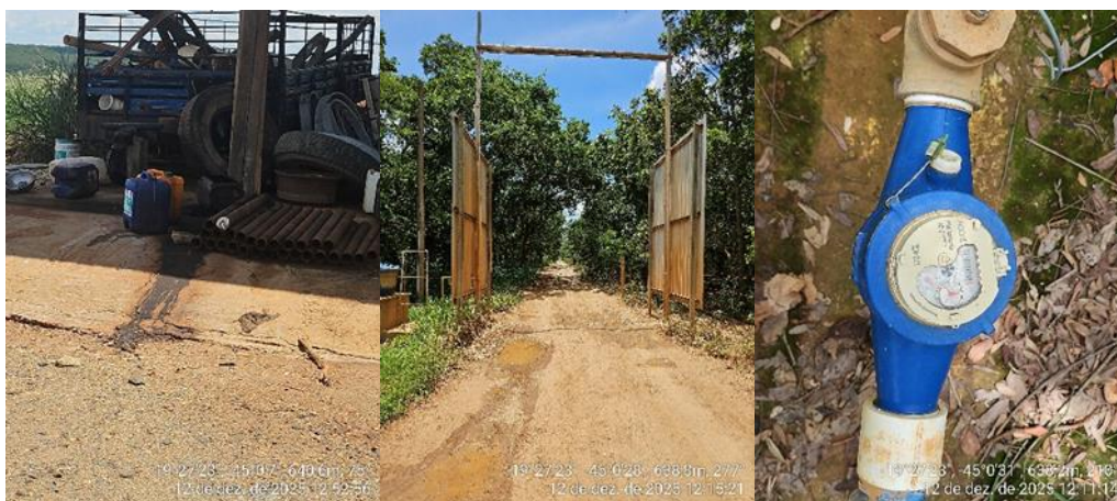
Foto 1- Óleo vazando de recipiente para o solo. Foto 2- Rodolúvio sem piso impermeabilizado, canaletas e caixa separadora água e óleo. Foto 3- Hidrômetro Poço 01
