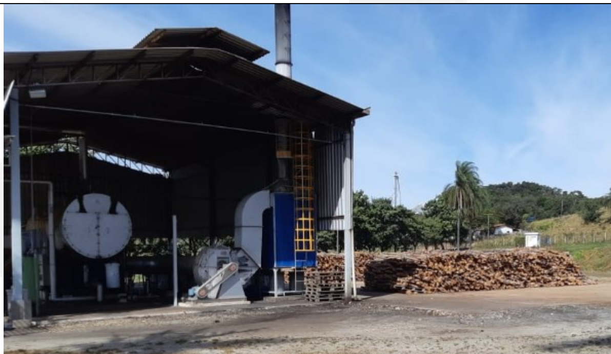
Foto 07. Área da Caldeira
