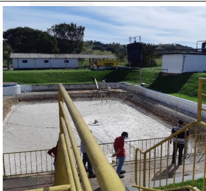
Foto 05. ETE – Tanque de Equalização
