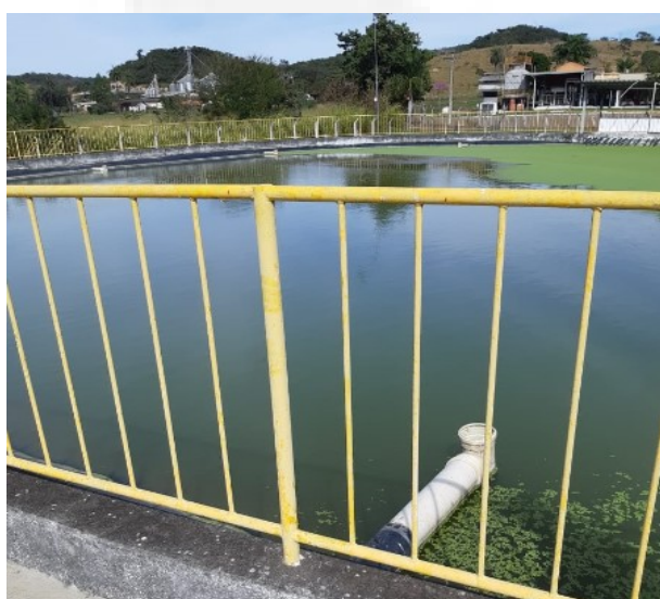
Foto 06. ETE – Lagoa Anaeróbia
