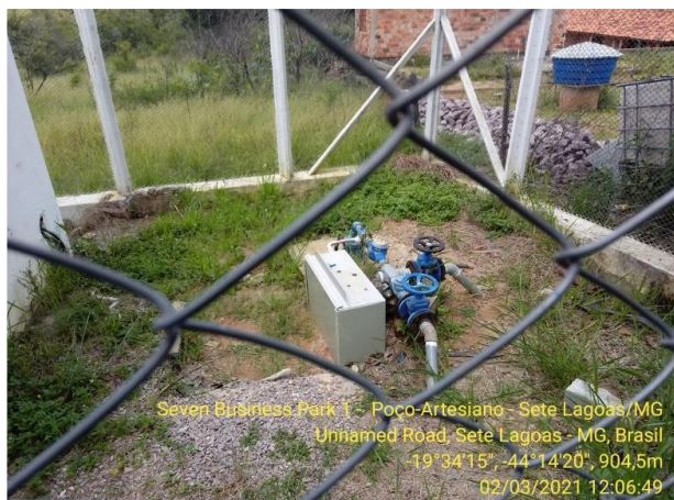
Foto 19 - Vista parcial do poço-tubular.
