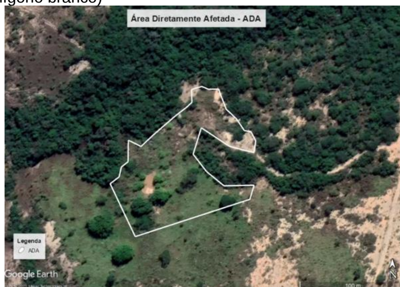
Figura 1. Imagem de satélite com a delimitação da Área Diretamente Afetada (ADA) (polígono branco)
