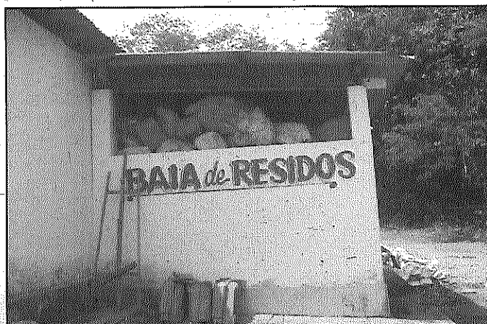
Foto 12: Local de armazenamento temporário dos resíduos sólidos.
