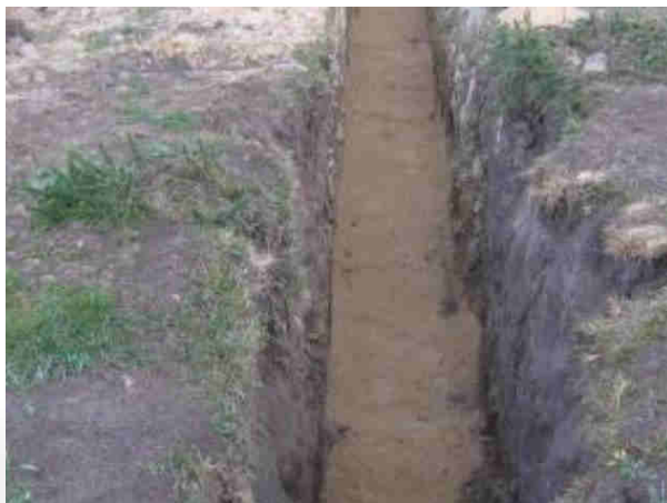
Figura 05 – Ilustração da abertura das valas para execução da passagem dos cabos. Fonte: Anjo Azul Consultoria Ambiental - PCA, 2016
