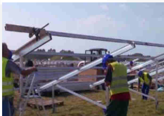
Figura 3 – Ilustração das estruturas de apoio dos módulos fotovoltaicos Fonte: Anjo Azul Consultoria Ambiental - PCA, 2016
