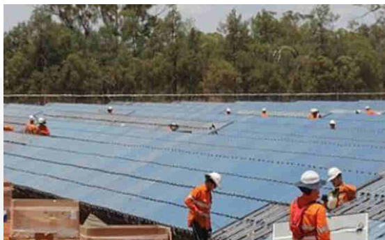
Figura 04 – Ilustração da montagem dos módulos fotovoltaicos Fonte: Anjo Azul Consultoria Ambiental - PCA, 2016
