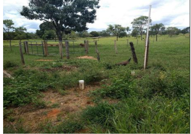
Foto 06 – Fossa séptica na casa sede
