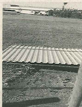
Figura 11. Caixa Separadora de Água e Óleo - CSAO
