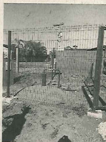
Figura 6. Poço 2 – captação de água subterrânea
