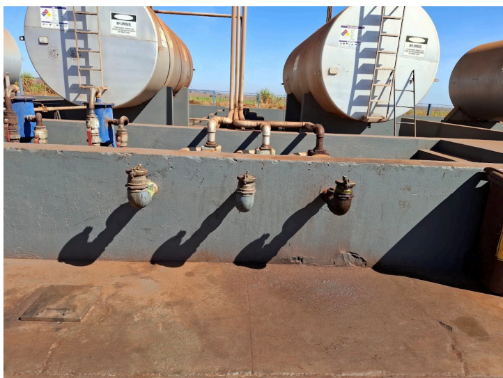
Tanques aéreos com bacias de contenção.
