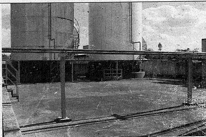
Foto 2: Dique de Contenção do Tanques
