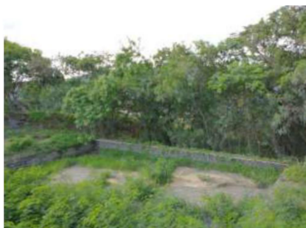
Foto 08: Gabião de amortecimento das águas da chuva.
