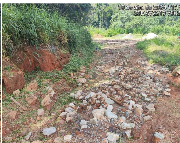
Foto 6: Arraste de material pela concentração de água de chuva na margem do acesso.
