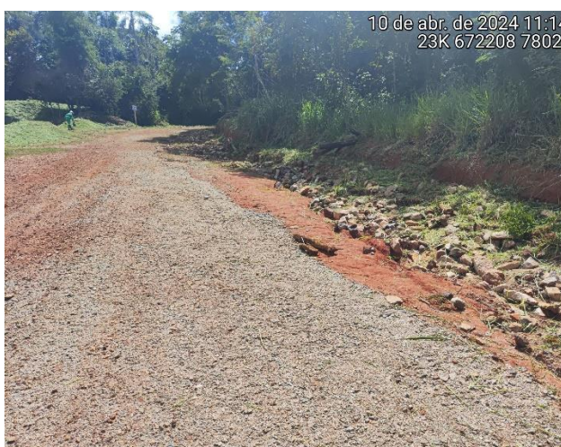
Foto 5: Início de formação de processo erosivo na margem do acesso, ao lado da ombreira esquerda.
