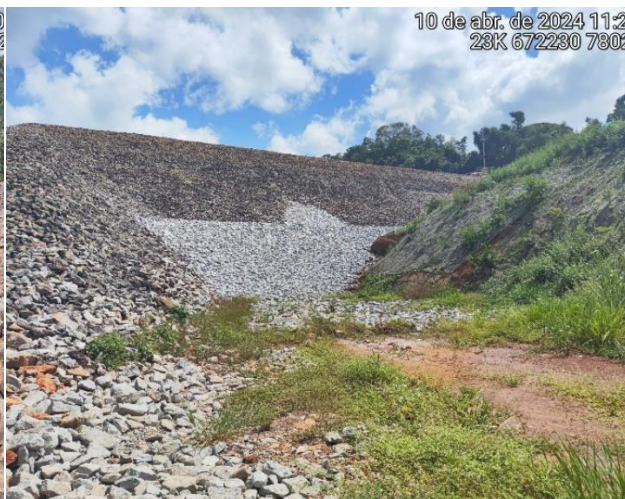
Foto 2: Porção do talude que recebeu estrutura de reforço (parte com rochas mais claras). No lado direito da foto, parte da área que foi necessária à supressão de Floresta Estacional Semidecidual.
