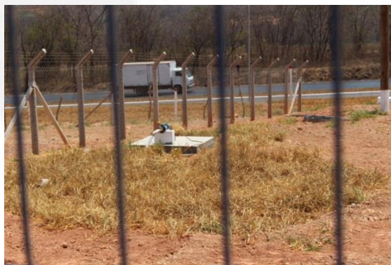
Foto 32 – poço tubular com hidrômetro e laje de proteção Foto 33 – área de troca de óleo veículos pequenos e no local o veeder-root (monitoramento intersticial) dos tanque de parede dupla da pista de abastecimento dos combustíveis gasolina e álcool.
