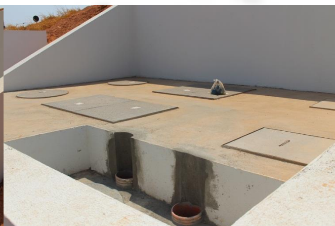
Foto 15 e 16 – caixas separadoras de água e óleo
