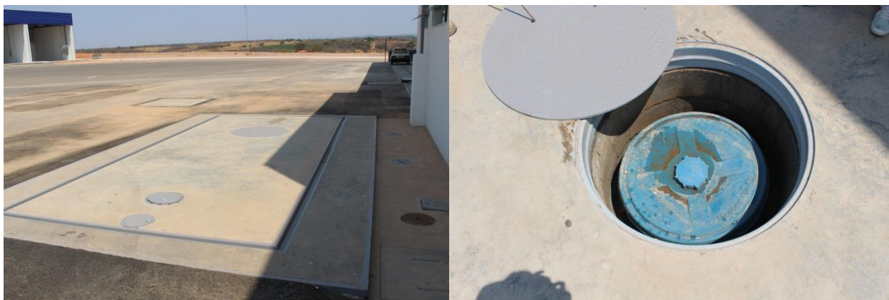
Foto 22 e 23 – tanque subterrâneo com capacidade de 15 m 3 para estocagem de óleo usado – este tanque contém boca de visita com sump;
