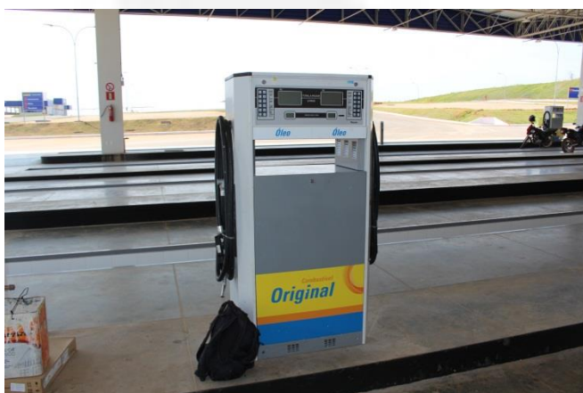
Foto 20 e 21 – bomba de óleo lubrificante com sump
