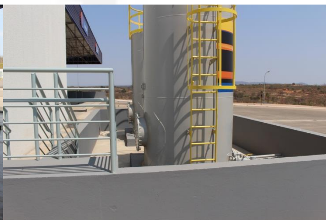
Foto 19 e 20 – área coberta para troca de óleo, com piso concretado com canaletas ligadas ao SSAO, e dois tanques aéreos de capacidade de armazenamento de 10 m³ cada de óleo para motor; sendo que os tanques aéreos estão dentro de uma bacia de contenção de concreto e com canaletas ligadas ao SSAO;
