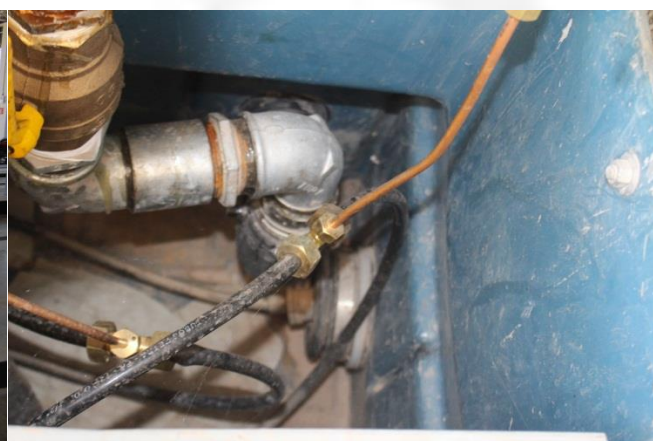
Foto 20 e 21 – bomba de óleo lubrificante com sump
