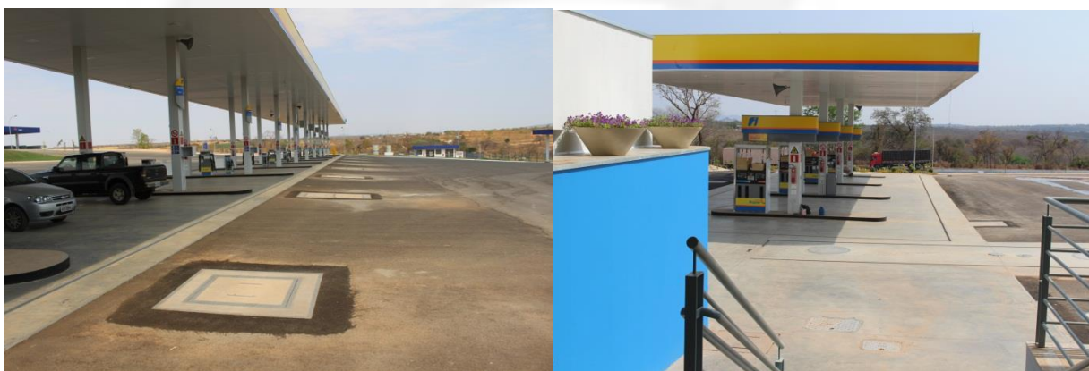
Foto 01 e 02 – pistas de abastecimentos de Diesel e Gasolina/Álcool com piso concretado, com canaletas abaixo da projeção do telhado, ligadas ao SSAO (sistema separador de água e óleo);
