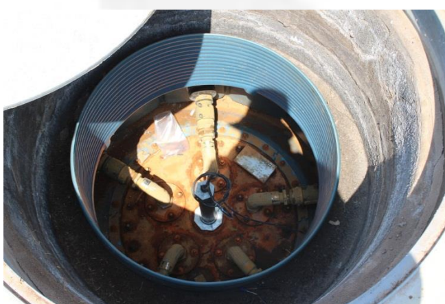
Foto 26 e 27 – tanques de combustíveis de parede dupla, com bocas de visitas com sump e monitoramento intersticial instalado (veeder-root);
