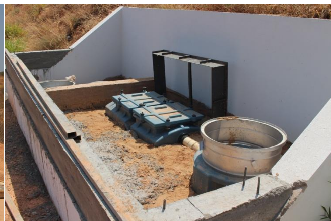
Foto 11 e 12 caixas separadoras de água e óleo – reservatório de concreto de 200 m 3 para reaproveitamento de água pluvial e de água tratada dos SSAO
