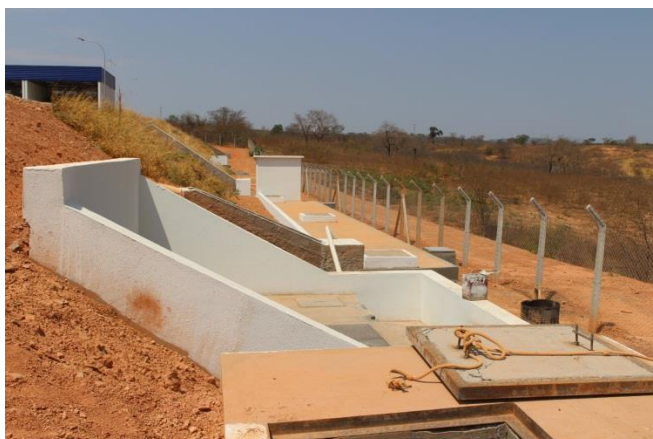
Foto 11 e 12 caixas separadoras de água e óleo – reservatório de concreto de 200 m 3 para reaproveitamento de água pluvial e de água tratada dos SSAO
