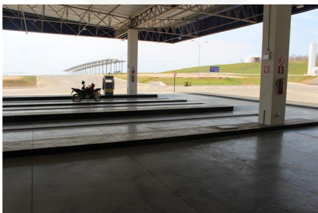
Foto 19 e 20 – área coberta para troca de óleo, com piso concretado com canaletas ligadas ao SSAO, e dois tanques aéreos de capacidade de armazenamento de 10 m³ cada de óleo para motor; sendo que os tanques aéreos estão dentro de uma bacia de contenção de concreto e com canaletas ligadas ao SSAO;
