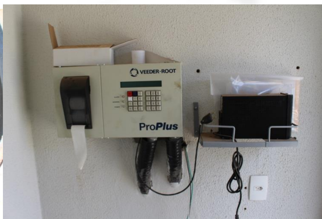
Foto 26 e 27 – tanques de combustíveis de parede dupla, com bocas de visitas com sump e monitoramento intersticial instalado (veeder-root);
