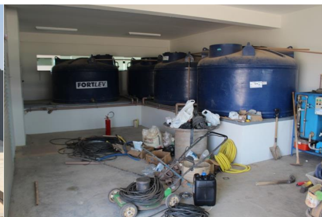
Foto 17 e 18 – área de lavagem de veículos e sistema de tratamento da água para reuso d'água para lavagem de veículos
