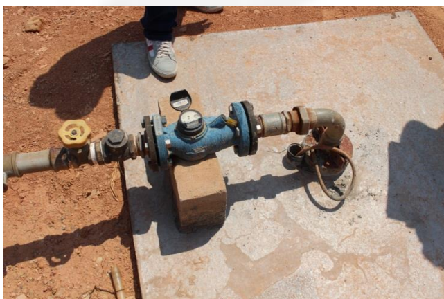
Foto 13 e 14 – instalação do hidrômetro e horímetro do poço tubular – com laje de proteção sanitária
