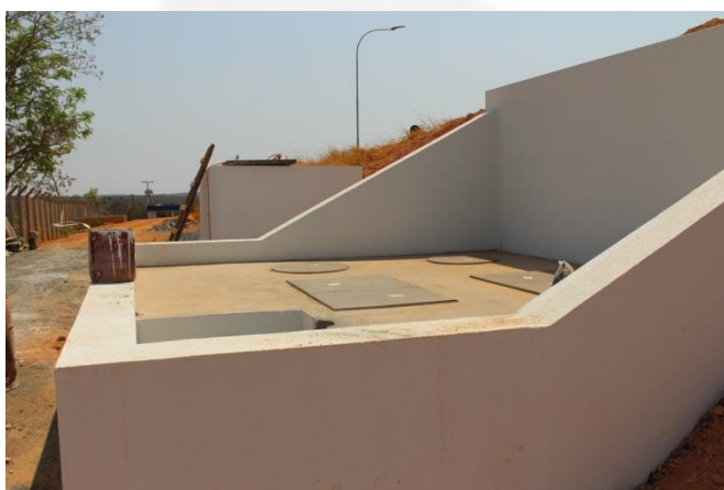
Foto 15 e 16 – caixas separadoras de água e óleo
