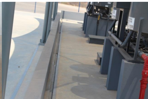
Foto 28 – bombas com sump e check- válvula Foto 29 – bateria de filtros de óleo em uma bacia de contenção dom canaletas ligadas ao SSAO;
