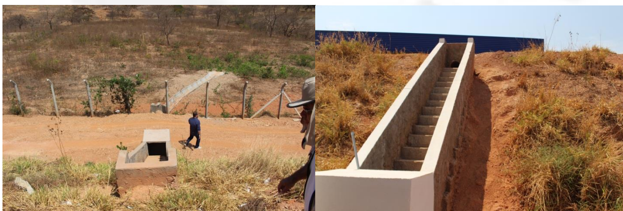
Foto 09 e 10 – sistema de drenagem de água pluvial com escadas de dissipação de energia;
