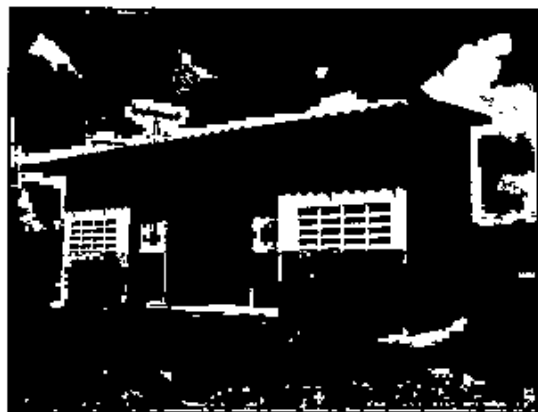
Figura 3: Casa de bombas
