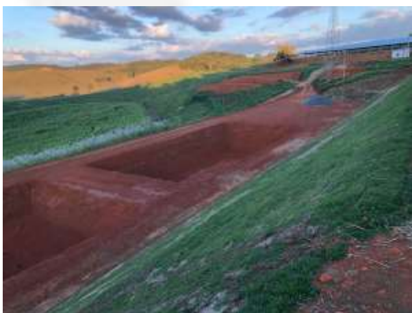
Figura 03: Lagoa de tratamento em fase de construção.
