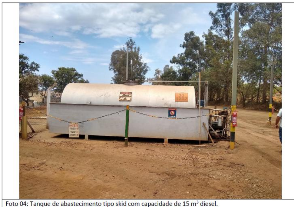
Foto 04: Tanque de abastecimento tipo skid com capacidade de 15 m³ diesel.
