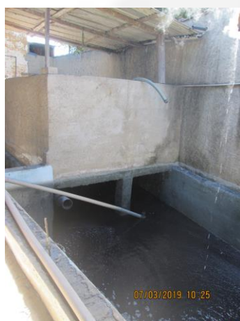
Figura 03: estruturas da ETE industrial – captação do efluente.
