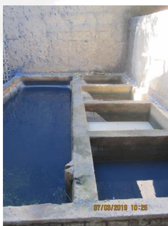
Figura 03: estruturas da ETE industrial – captação do efluente.
