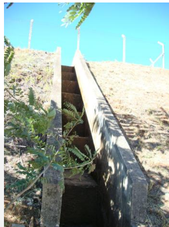
Foto 06. Drenagem Pluvial
