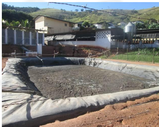
Foto 2: tanque coletor do efluente agroindustrial bruto
