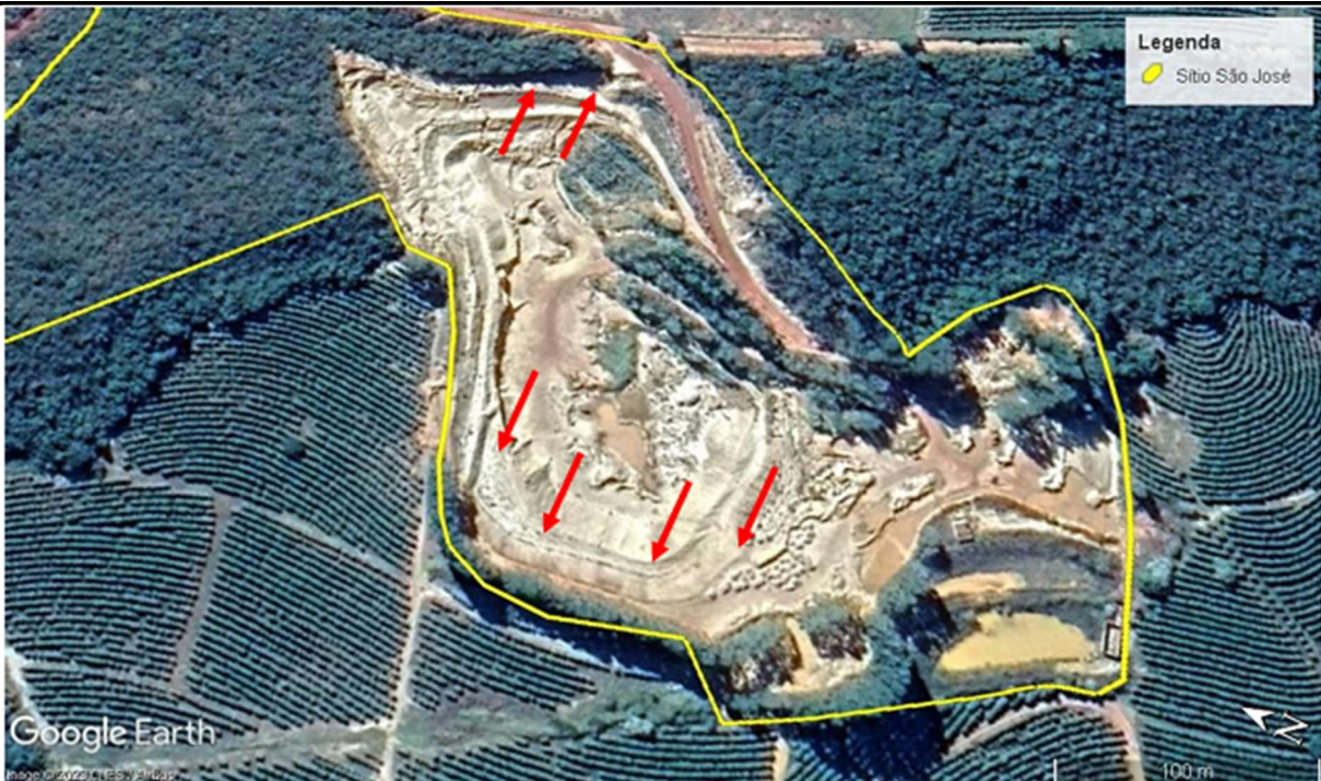
Figura 2 – Bermas e taludes onde foi proposto o plantio dos pequis. Fonte: documento SEI 76019546.
